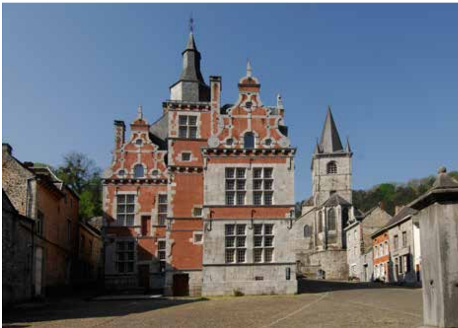
La Maison du Patrimoine Médiéval Mosan à Bouvignes.
