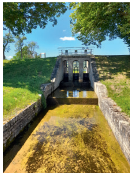
Le régulateur automatique de Cercey.
