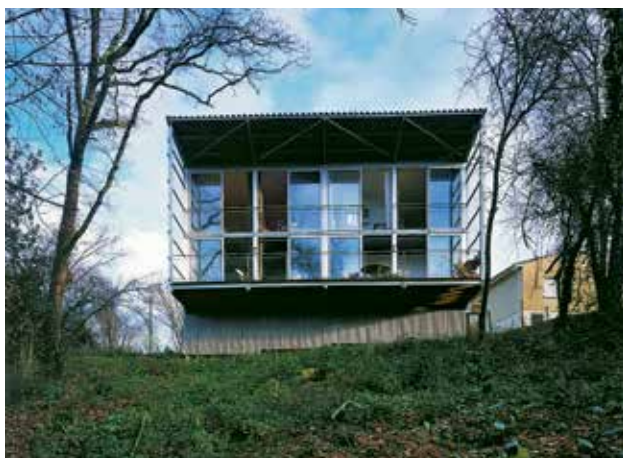
Une maison adaptée à son terrain.
