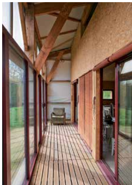
Une coursive qui isole aussi de l'extérieur.
